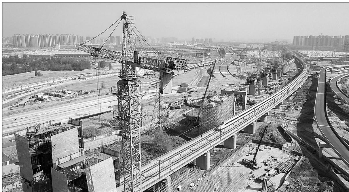
4月10日,郑万高铁跨越郑西高铁16500吨转体斜拉桥正在紧张施工。由中交二航局承建的国内最大横向曲线转体斜拉桥,是郑万高铁关键控制性工程。该桥采用“先建后转”方式施工,目前正在进行中塔柱第9节施工,预计今年10月完成转体。⑨3 聂冬晗 曹文方 摄
